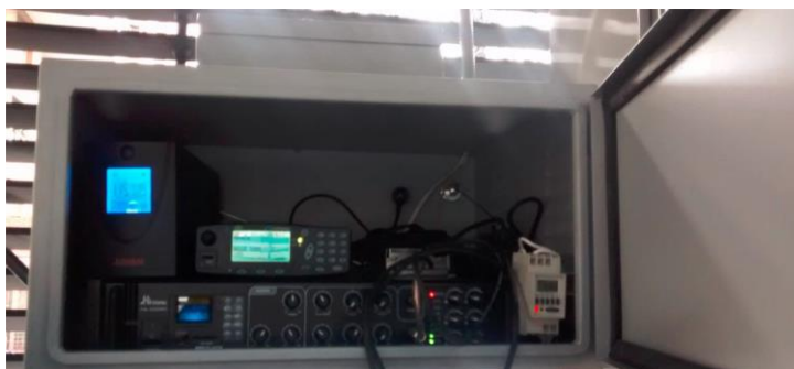
Figura 4. Equipamiento al interior del rack Estación Marly –UPS, amplificador, equipo móvil MDT-400 Teltronic, micrófono alámbrico, Temporizador-.
