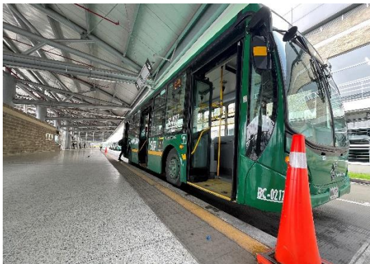
Señalización podotáctil de alerta
