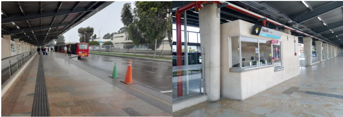
Señalización podotáctil guía en infraestructura nueva
