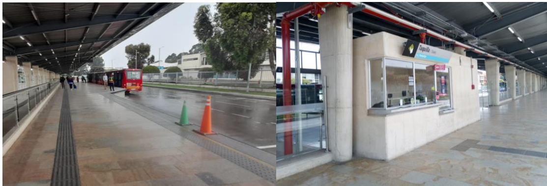
Señalización podotáctil guía en infraestructura nueva
