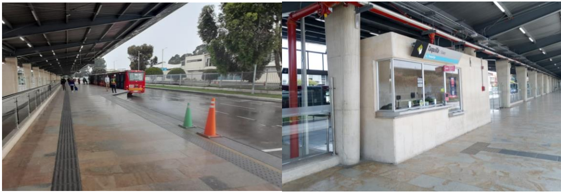
Señalización podotáctil guía en infraestructura nueva
