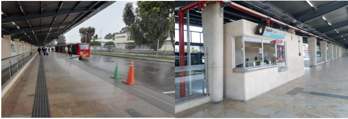
Señalización podotáctil guía en infraestructura nueva
