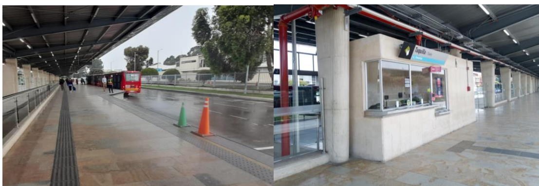
Señalización podotáctil guía en infraestructura nueva
