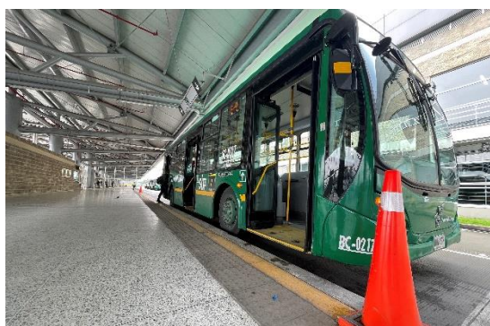
Señalización podotáctil de alerta
