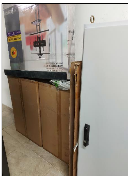
Cajas de cartón en la parte posterior de la UPS (generan riesgo de conato de incendio, no forma parte integral del lugar y afectan el orden y la libre circulación del personal requerido para atender una eventual contingencia eléctrica)
