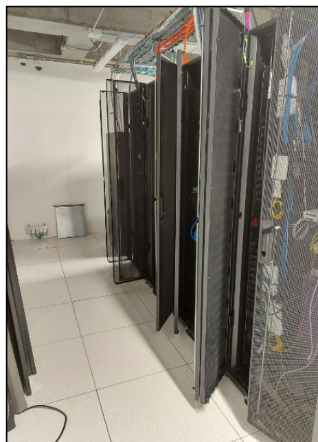
Puertas de los gabinetes rack abiertas UPS (inadecuada protección de los activos tecnológicos, posible pérdida de información, dificulta la libre circulación del personal)
