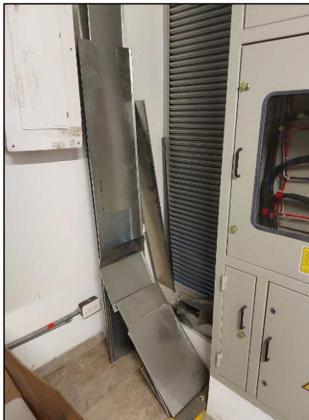
Secciones de lámina (no forman parte integral del lugar, dificultan la libre circulación del personal requerido para atender una eventual contingencia eléctrica)
