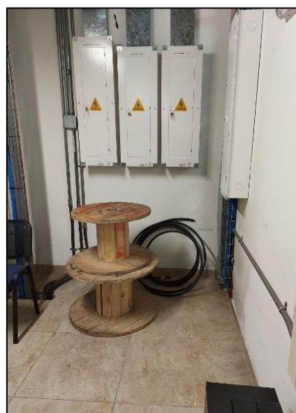
Dos carretes de madera (favorecen la aparición conatos de incendio) y un rollo de cable (no forma parte integral del lugar). Ambos afectan el orden y la libre circulación del personal requerido para atender una eventual contingencia eléctrica.
