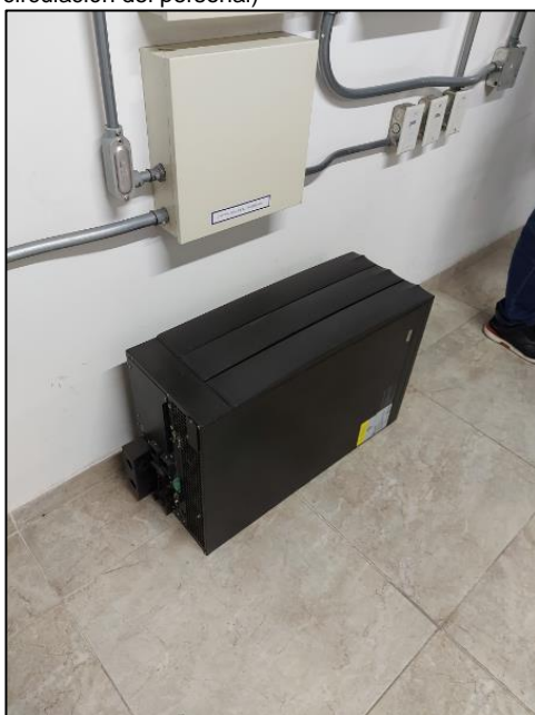
Gabinete de UPS (inadecuada protección de los activos tecnológicos, posible pérdida de información, dificulta la libre circulación del personal)
