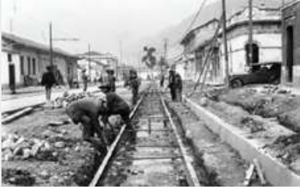
Foto 4. Instalación de los rieles del tranvía, carrera Séptima
